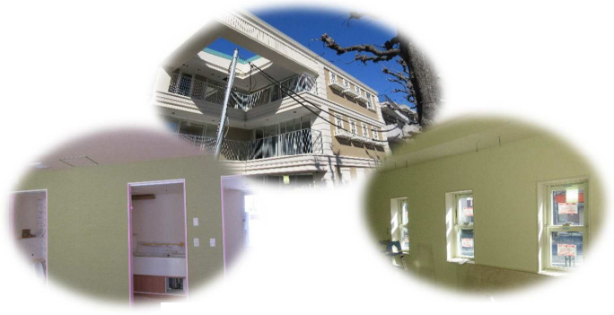
内装も順調に進み、渋谷東より、一足早く竣工となりそうです!
